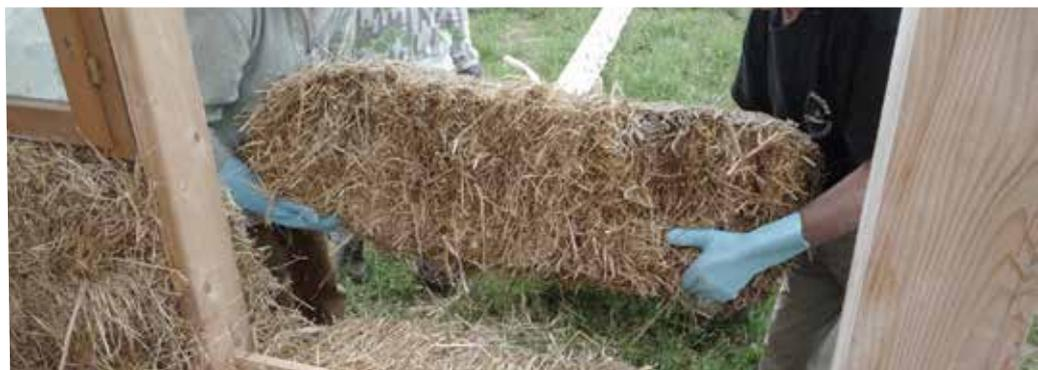
Dans cette technique, une ossature retient la paille comprimée. Elle intervient comme isolant et n'intervient pas dans le calcul de la statique du bâtiment. Ce qui la rend très efficace en parasismique. La paille comprimée agit comme un ressort et elle va empêcher le bâtiment de se fracturer. On peut alors créer des bâtiments avec les mêmes avantages que ceux en ossatures bois classiques.
