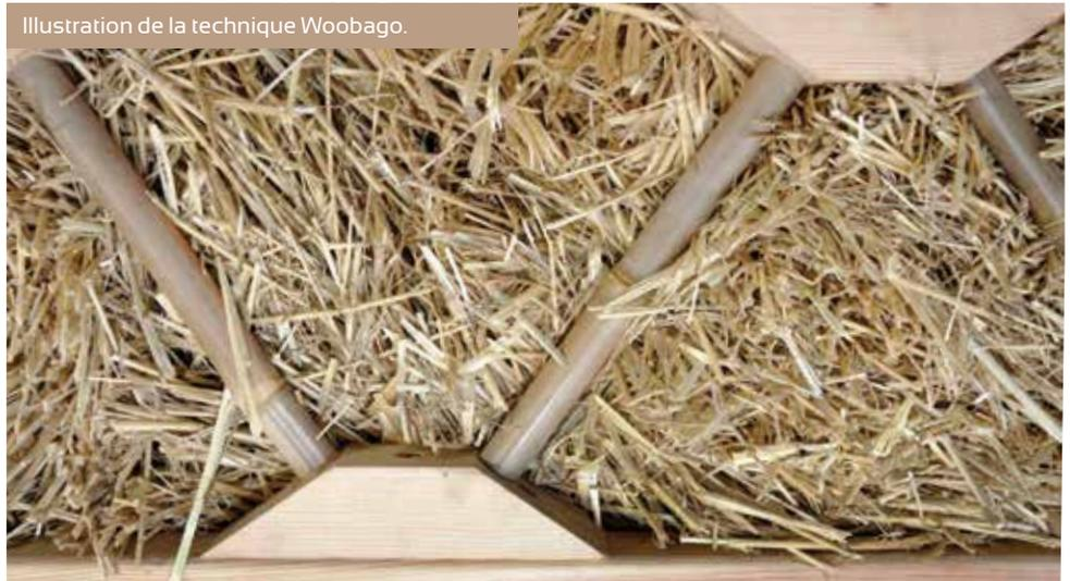
Des techniques utilisent la paille porteuse comprimée. Il s'agit de resserrer la paille de la laisser se relâcher une fois posée.
