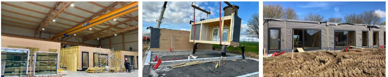
A la demande de La Dinantaise, société de logements publics, une dizaine de logements sociaux ont été mis en construction sur le plateau de Gemechenne. Il s'agit de modules 3D en ossature bois entièrement préfabriqués en atelier. Chimsco est en charge du gros-œuvre fermé (châssis et couverture en EPDM compris) et l'entreprise Kaiser Construct du parachèvement.
