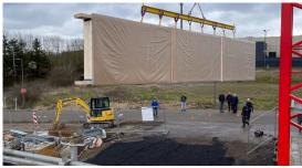
Ce nouvel immeuble de bureaux est le premier bâtiment isolé avec de la paille à voir le jour au Luxembourg. Construit sur trois niveaux avec une structure poteaux-poutres en béton et des façades préfabriquées en ossature bois, il accueillera d'ici 2025 le siège d'une entreprise de voiries.
