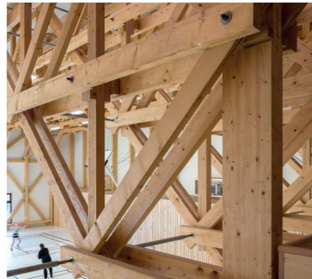
Utilisation de petites sections en épicéa pour la charpente
